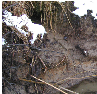
Erdbau am Ufer
