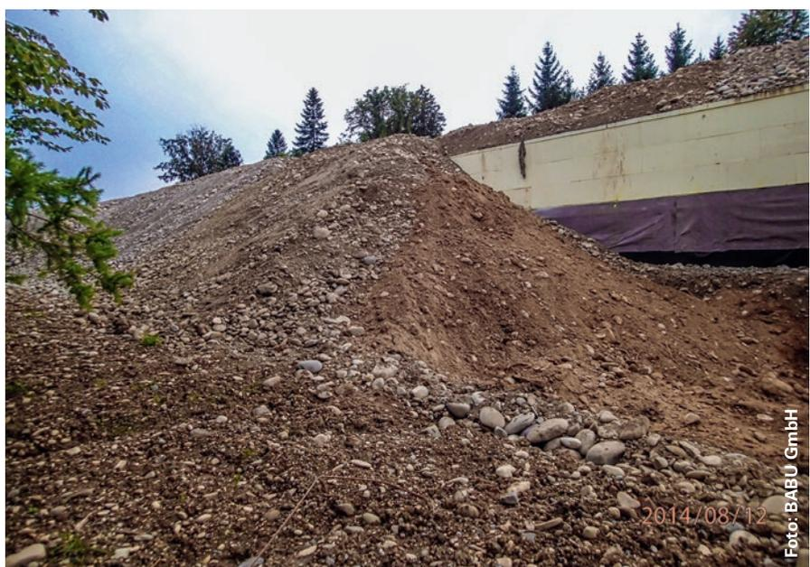
*«Sandwich»-Bauweise zur langfristigen Zwischenlagerung des Unterbodens in der als Mangelbiotop ausgestalteten Geländemodellierung*
