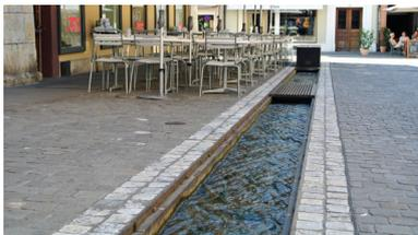
Dieser Bach wurde begradigt und kanalisiert. Er fliesst teils überirdisch, teils durch Rohre unter der Erde. Das Bachbett besteht aus Beton. In diesem Bach finden sich keine Kleinlebewesen. Abfall von Spaziergängern oder der Strasse kann leicht in ihm landen.
